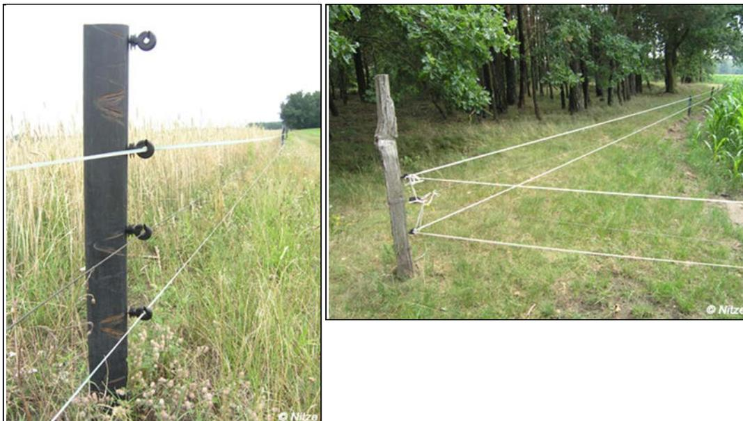
**Abb. 34** Streckenpfahl aus Kunststoff-Recyclingmaterial und Eckpfahl aus Holz (Eiche, Robine), Verdrahtung 2x Bandlitze + 1x Stahldraht, Höhe 60 cm. Zukünftig wird die untere Bandlitze durch Stahldraht ersetzt, da diese oft zu sehr einwächst und Reparaturen erschwert. Die Höhe von 60 cm reicht für Schwarzwild aus.
